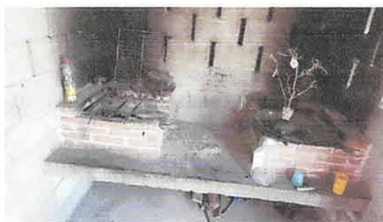
Foto 3: Reparación de dos estufas rurales, con plancha de metal cada una y su respectiva chimenea para extracción de humo.
