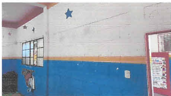
Foto 5: Aula 1, Elaboración de ventana de 2.10 de largo por 1 metro de alto, con paletas de vidrio y estructura de aluminio.
