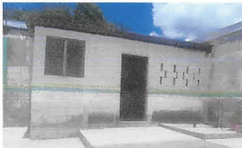
Foto 1: Sustitución de estructura de soporte de metal y lámina, por estructura metálica y lámina troquelada aluzinc calibre 26 en área de cocina.
