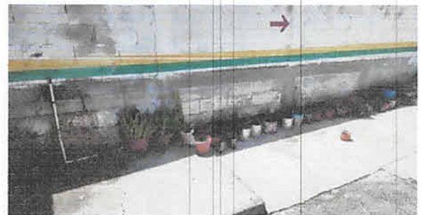
Foto 12: Elaboración de una pila de concreto, medida 1.60 por 1.30 metros y dos lavaderos.
