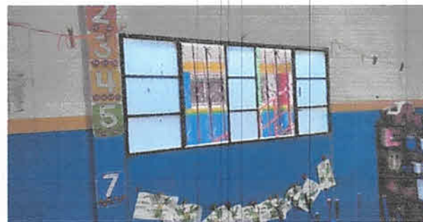
Foto 6: Aula 2, Sustitución de ventana de metal y vidrio por ventana de paletas de vidrio y estructura de aluminio medida 2.10 de largo por 1 metro de alto
