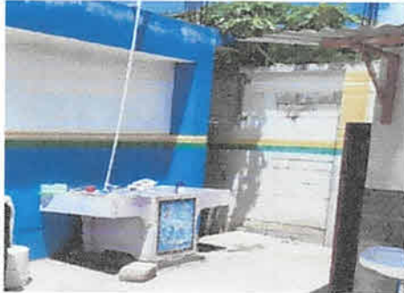
Foto 13: Instalación de galera estructura metálica y lámina troquelada aluzinc calibre 26 área de pila.
